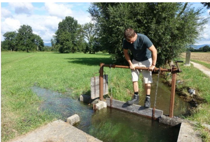
Foto: Schliessen der Brütschen (Wehre) in den Wässermatten Oberraargau
